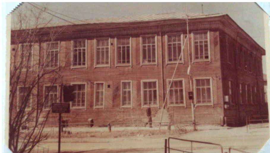
Рис. 4. Здание Якутской Второклассной учительской школы ( дата постройки: 1914г. ) ныне школа №5 г. Якутска ( на фото: 1989г. )
